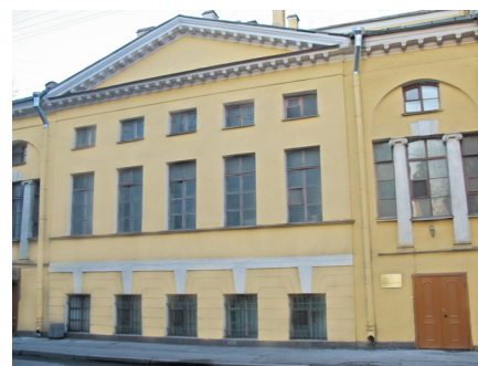
Центральный офис ОАО «ЭлектроРадиоАвтоматика»
