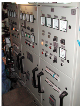
Монтаж судовых электрораспределительных устройств
