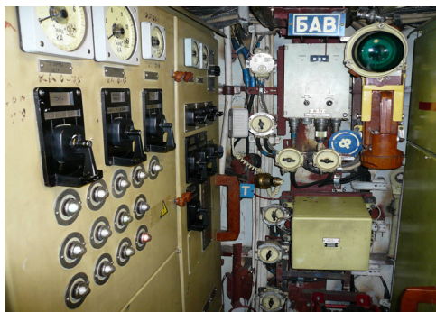
Монтаж электрооборудования, систем, постов
