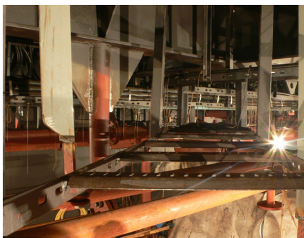
Слесарно-сварочные работы по установке элементов крепления кабельных трасс
